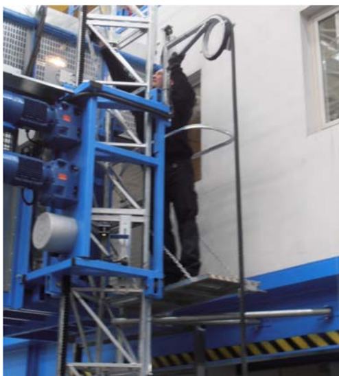
PLATAFORMA AUXILIAR PARA MONTAJE DE ANCLAJES
